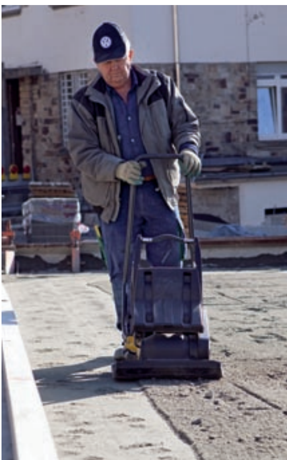
BP 10/35: Небольшая и легкая виброплита для применения в углах и труднодоступных зонах.
