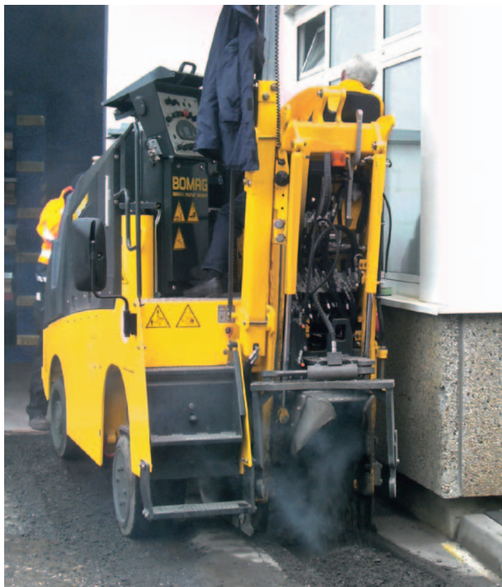
Точный подъезд к стене дома? Без проблем.
