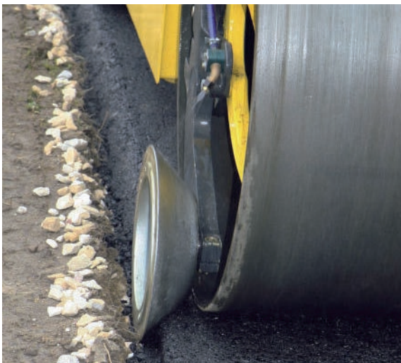
Резец для кромки делает края ровными.
