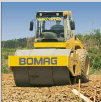
Уплотнение крупного щебня при устройстве основания дороги.
