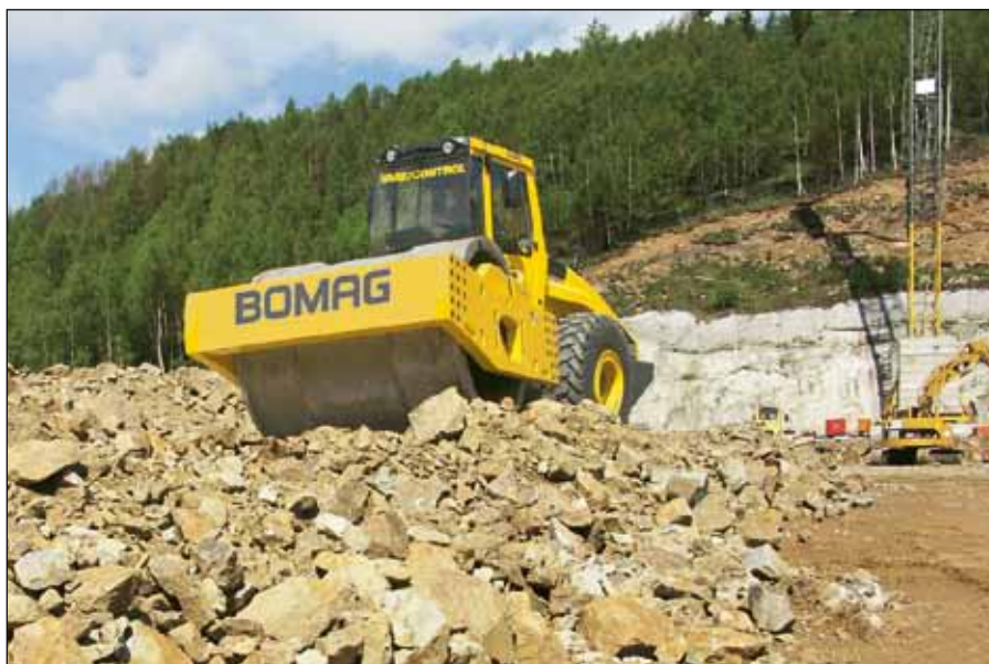
Грунтовый каток BW 226 DI-4 BVC уплотняет грунт при строительстве оградительной плотины от наводнений.
