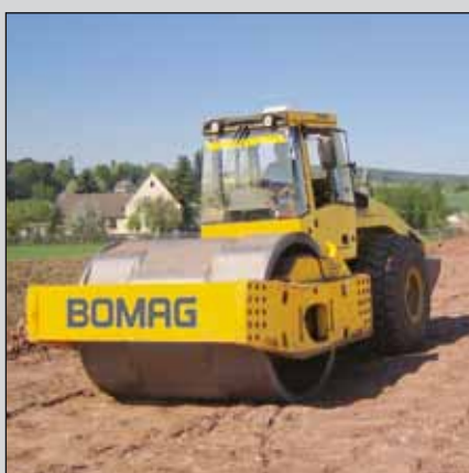
Грунтовый каток с полигональным вальцом при проведении земляных работ.
