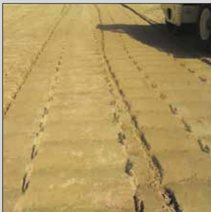
Узор стиральной доски на поверхности обеспечивает очень хорошее сцепление между отдельными слоями грунта.
