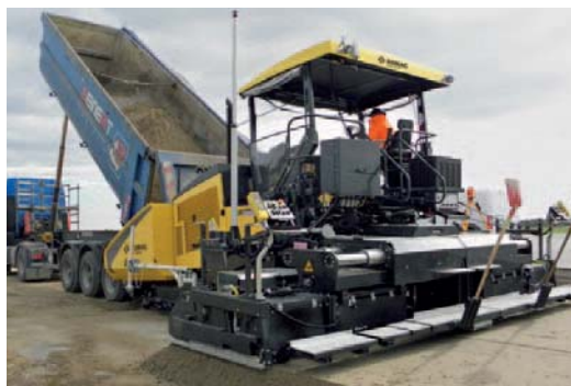
Несущий слой (d = 28 см) на цементном связующем, при строительстве в аэропорту.
